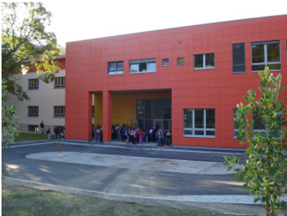
Prenovljena osnovna šola na Dobrni
